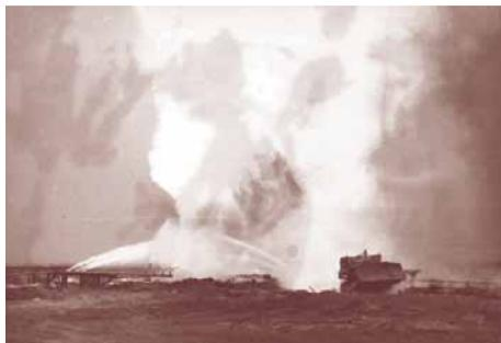
Гребенки с лафетными стволами на устье скважины
