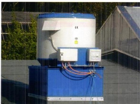
Рис. 5. Встроенная система самодиагностики в крышный вентилятор дымоудаления серии BVD
