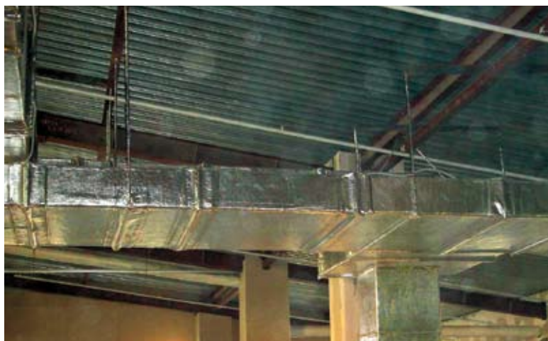
ЕТ VENT — линия систем огне-, тепло- и звукоизоляции вентиляционных воздухопроводов и коробов дымогазоудаления, обеспечивающих пределы огнестойкости от 30 до 180 мин. Срок эксплуатации равен сроку службы самой конструкции
