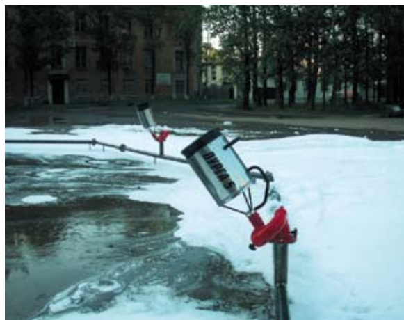
Автономный пожарный модуль с УКТП «Пурга-30»
