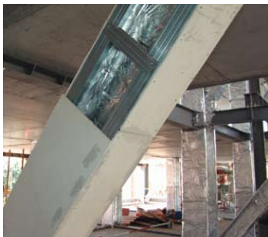
ЕТ МЕТАЛЛ — линия систем огнезащиты металлических конструкций всех видов (колонны, балки, фермы, ригели, связи и т.д.) с пределами огнестойкости от 60 до 180 мин. Срок службы этих систем — не менее 25 лет
