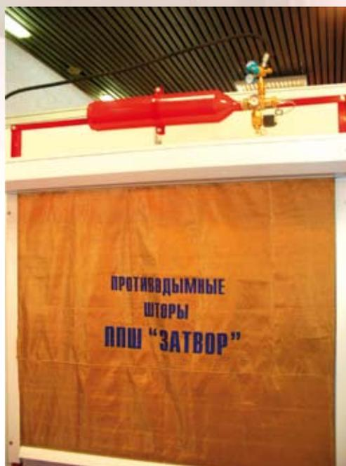
Принцип работы завесы заключается в открытии клапана ЗПУ при подаче электрического сигнала от станции управления и подаче сжатого газа, содержащегося в баллоне, через понижающий редуктор и рукав высокого давления на механизм пневматического привода опускания (подъема) завесы. Штора может монтироваться на стену, потолок или на стойки-направляющие.
