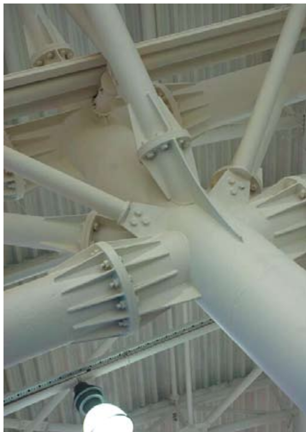
Рис. 1. Огнезащита металлоконструкций краской ОЗК-01 (R 45 — R 90)
