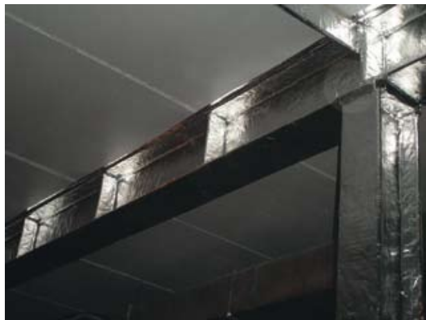
Рис. 2. Огнезащита металлоконструкций материалом «Изовент-М» (R 90, R 150)
