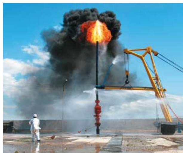
Фото 5. Наведение запорно-устьевой сборки на устье горящей скважины при проведении занятий на тренажере
