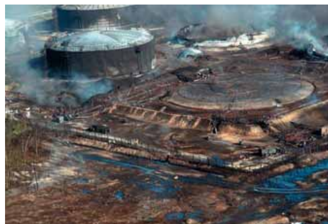
Рис. 8. Характер группового пожара при распространении пламени по газовой обвязке с возникновением детонации
