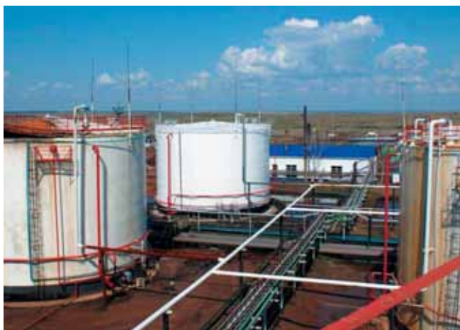
Рис. 1. Система газовой обвязки резервуарного парка
