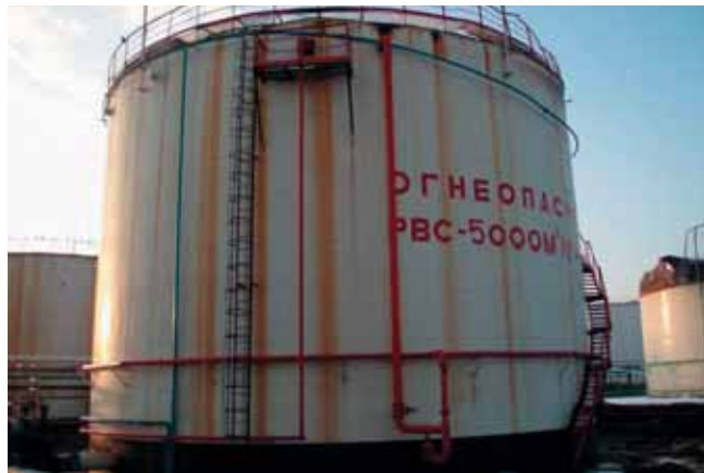
Рис. 3. Фрагмент системы пенного пожаротушения
