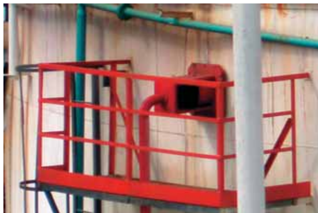
Рис. 10. Фрагмент установки пенной камеры на РВС № 6
