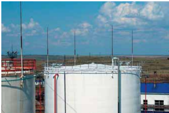
Рис. 2. Техническое решение молниезащиты резервуара
