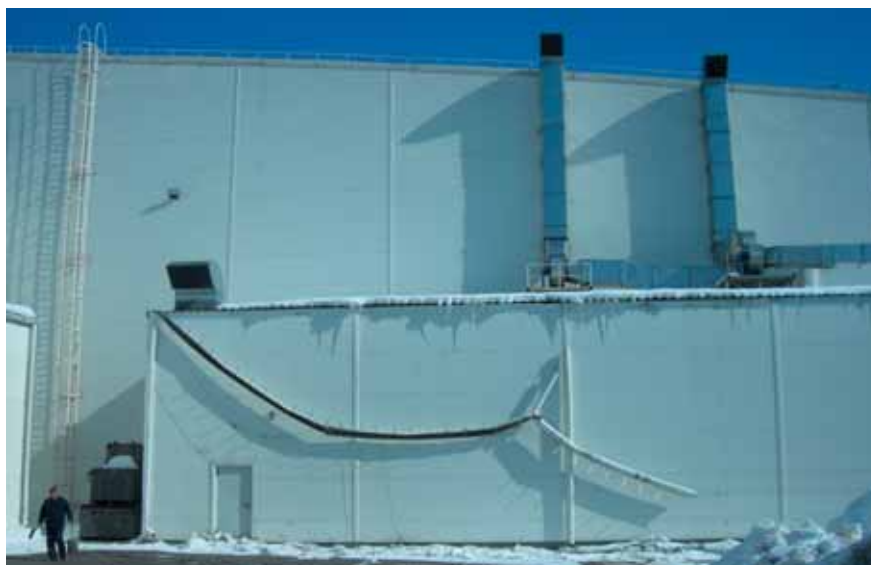
Из-за несовершенной системы обогрева внешних водостоков и несвоевременной физической очистки (сэкономили на обслуживающей организации) в результате скопления и падения огромных глыб льда было повреждено имущество (водостоки, крыши прилегающих зданий, внешние системы вентиляции и пр.) на сумму свыше 8 млн рублей. В выплате по убытку страховщик отказал
