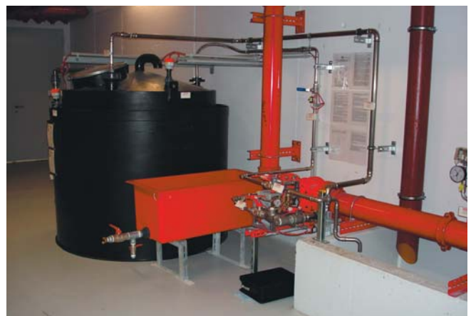
Рис. 2. Элемент системы пожаротушения с дозатором FireDos и баком для хранения пенообразователей
