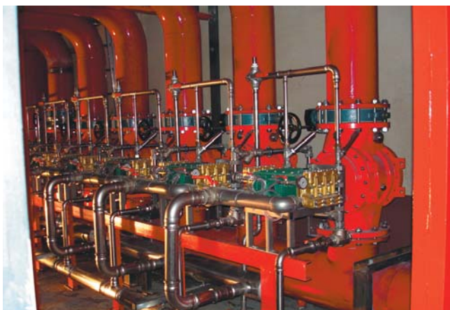
Рис. 1. Применение дозирующих устройств FireDos в системах пожаротушения крупных объектов
