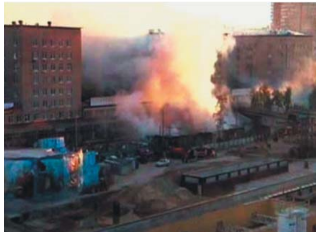
Рис. 2. Серьезный пожар 19 мая 2010 г. у нового тоннеля на развязке Ленинградского и Волоколамского шоссе на севере столицы: загорелись торговые павильоны рядом со строительной площадкой. Площадь пожара составила 300 м 2
