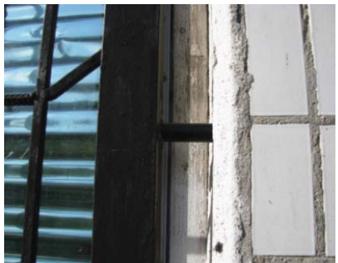
Рис. 2. Принципиальная схема запорно-распашного устройства (а) и «жертва» его конструкции — одно из отверстий в стене (б)
