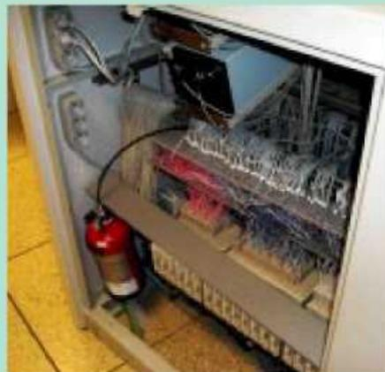
УГПТ, расположенная в шкафу с электронным оборудованием
