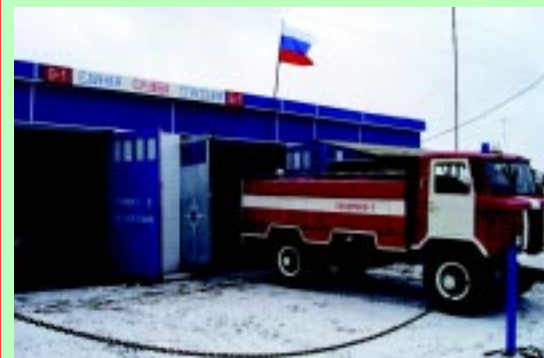
Пожарное депо в с. Болхуны Ахтубинского района
