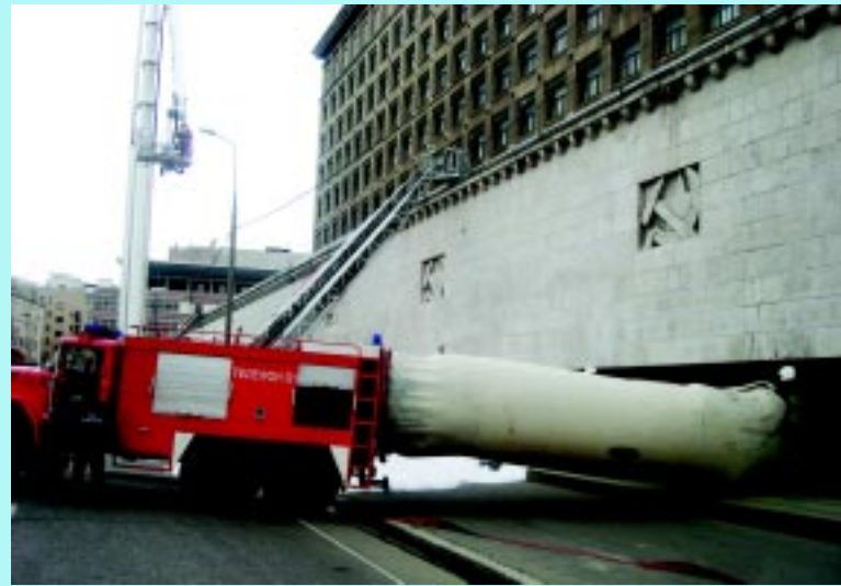
В окно подвала здания установлен дымосос
