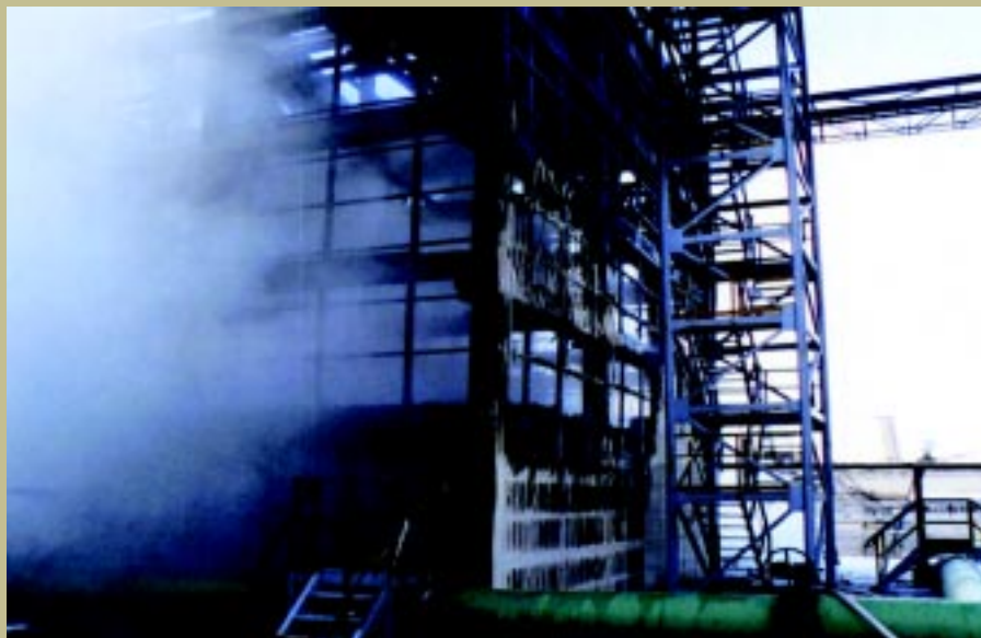
От сгоревшей градирни остался только железобетонный каркас
