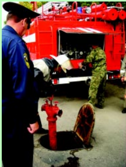
Проверка пожарного гидранта
