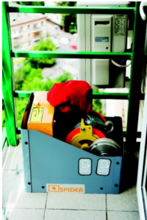
Рис. 6. Устройство канатно-спусковое пожарное «СПАЙДЕР», установленное на балконе на 23-м этаже жилого дома
