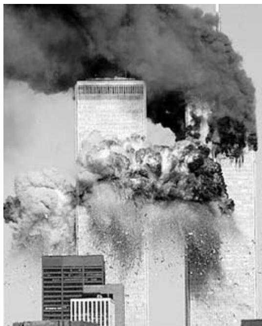
Рис. 2. Прогрессирующего разрушения зданий ВТЦ-1 (справа) и ВТЦ-2 в момент удара самолета и взрыва его топлива в зоне удара 11 сентября 2001 г. не произошло, так как вскрывшееся остекление окон сыграло роль взрывозащиты здания
