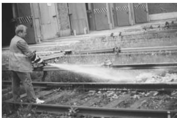
**Рис. 5.** Тушение очага возгорания под контактным рельсом в депо
