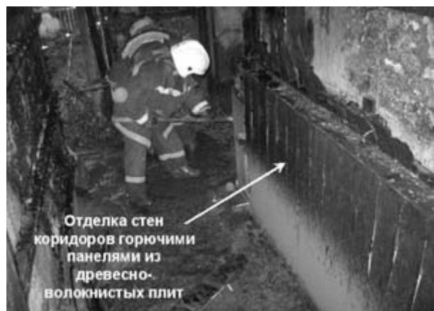
Рис. 4. Горючая отделка стен коридоров торгового центра “Пассаж”
