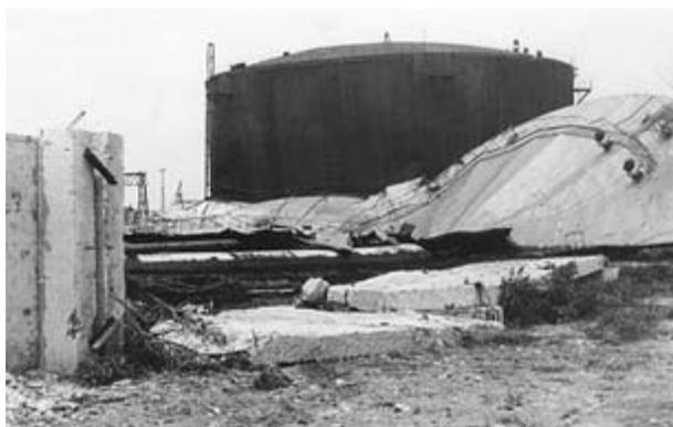
Рис. 4. Состояние железобетонного наружного ограждения после аварии
