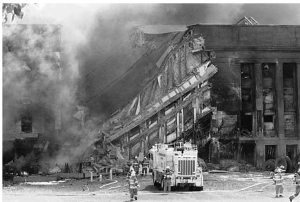
**Рис. 4.** Прогрессирующее обрушение наружного кольца здания Пентагона во время событий 11 сентября 2001 г.
