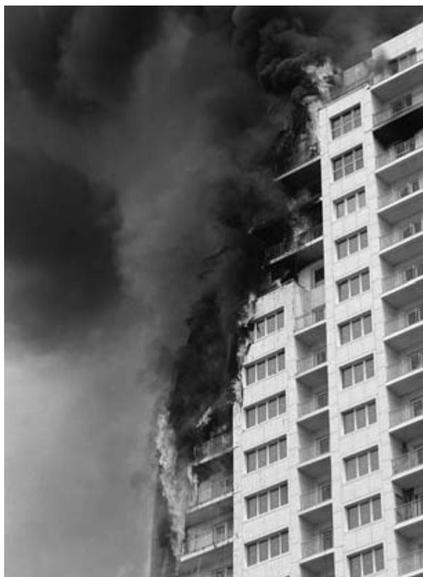
Распространение огня по фасаду здания, утепленного пенополистиролом [13]
